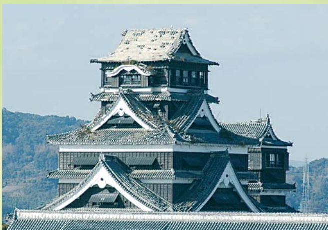
被災した熊本城本丸の様子
