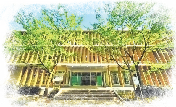
中央図書館入口
