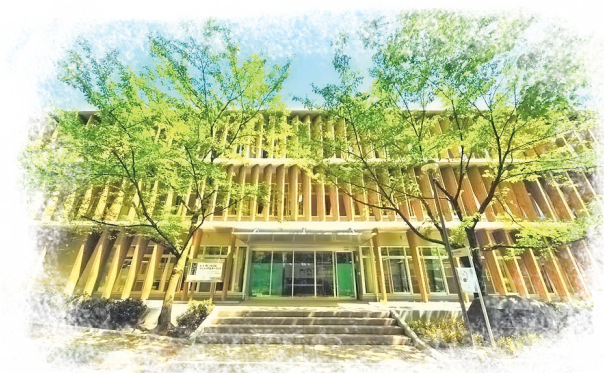
中央図書館入口
