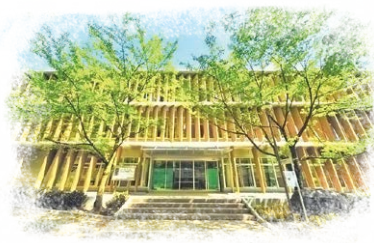
中央図書館入口
