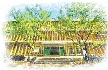
中央図書館入口
