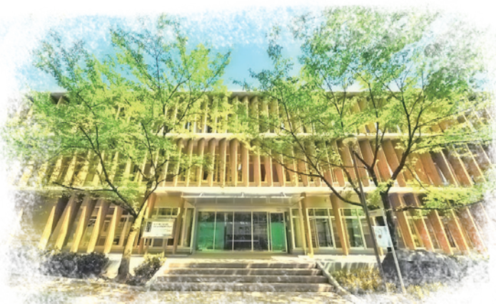
中央図書館入口
