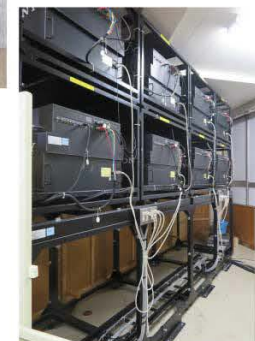
映写機械室 モニター裏
