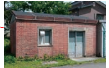
医学部倉庫 松本歩兵第五十連隊ゆかりのレンガ造り倉庫
