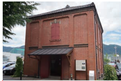
繊維学部資料館 有 旧貯蔵庫 蚕糸専門学校設立当初からあり、上田キャンパスでは最も古い建造物
