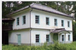
旧長野県師範学校教師館 県 (長野市上ヶ屋館原) 長野市立図書館の地にあった長野 県師範学校の教師館が移築されて いる
