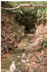
芋ノ田の横井戸 横井戸出口 明治の頃に掘削され約720mの地下水路 構内の農場の灌漑用水に利用されている
