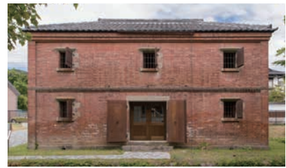
信州大学教育学部同窓会 赤煉瓦館 有 旧長野県庁書籍庫
