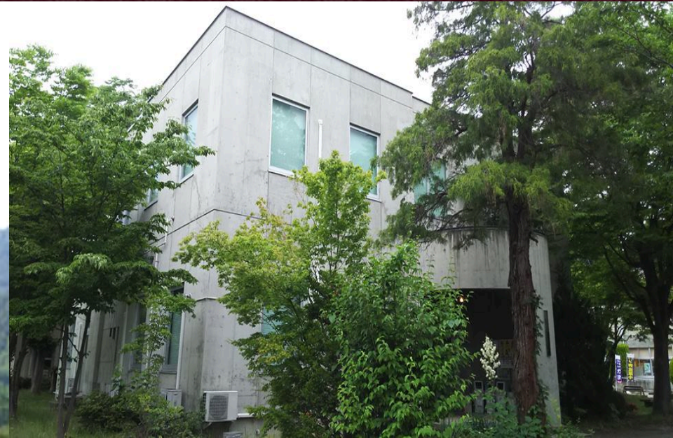
次世代型学び研究開発センター棟(1976年完成)
