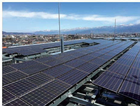
太陽光発電パネルは屋上面を含む 4 面に計 1332 枚あり、発電能力は約 300kW
