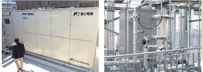
100kWのリン酸型燃料電池と排熱利用のための吸収式冷凍機
