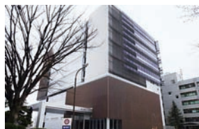
国際科学イノベーションセンター アクア・イノベーション拠点 (COI) の中核施設
