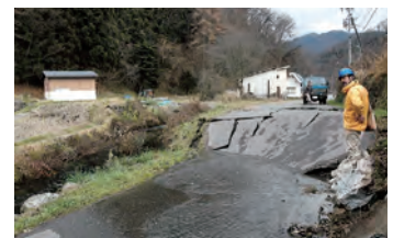
地表に現れた神城断層による撓曲 (地震発生翌日)
