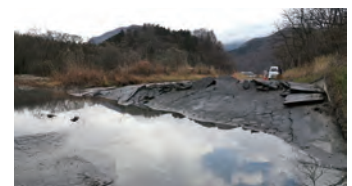
松川左岸堤防道路 道路東側が西側に対して隆起し、撓曲が生じている。
