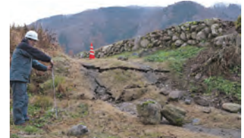
大出北 農道に生じた撓曲
