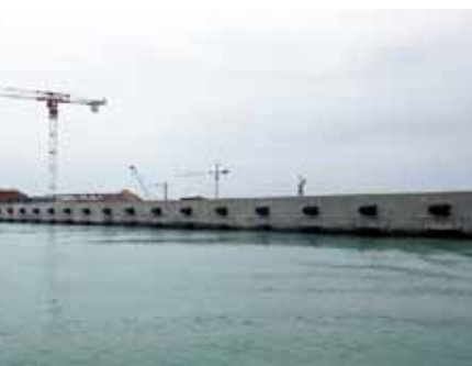
モーゼ計画の工事現場を観光地化し、観光客の誘客へ取り組んでいる。
