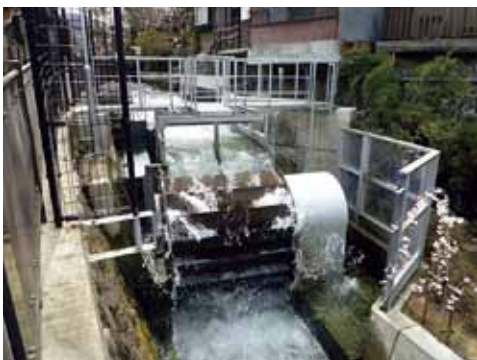
図1 都留市家中川市民水力発電所の「元気くん2号」稼働の様子
