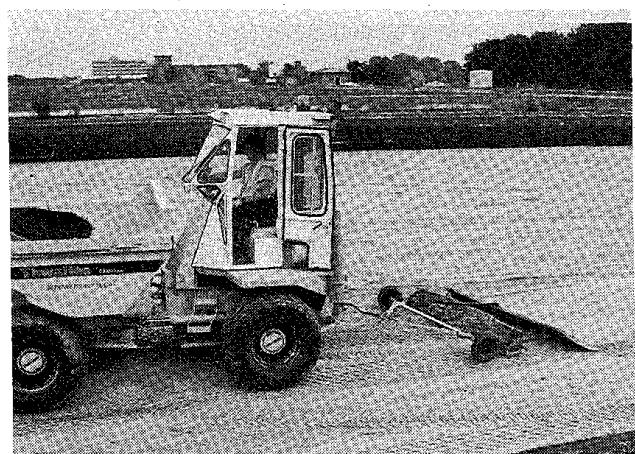
写真13 機械による砂層表面の平滑化作業。
