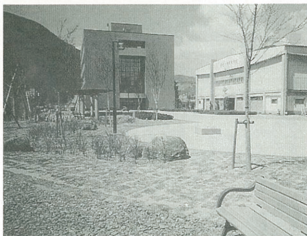
教育学部西校舎と整備された正門付近
