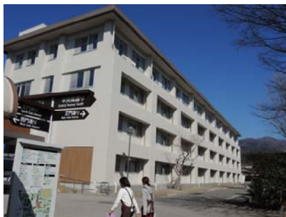
写真2 完成した南棟（南面）
