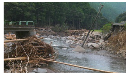
自然災害による橋桁の流出
