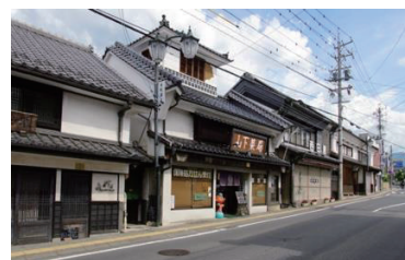
土蔵造の町家が建ち並ぶ、須坂（長野県須坂市）の歴史的町並み。令和6年に重要伝統的建造物群保存地区に選定された。
