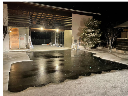
ハイブリッド融雪舗装の融雪状況
