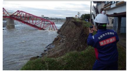
上田市諏訪形地先の千曲川堤防欠損と鉄道橋梁一部崩落 (2019年10月15日)
