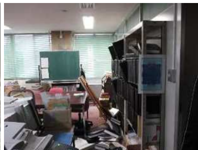
耐震固定実施済の棚から 大量の書籍が落下
