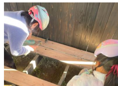
床板に釘を打ち付けている様子
