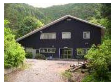
手良沢山ステーション
