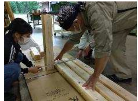
図 6. 部材の長さを確認 長さが足りないと組めない
