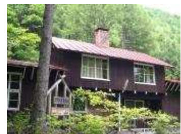
西駒ステーション
