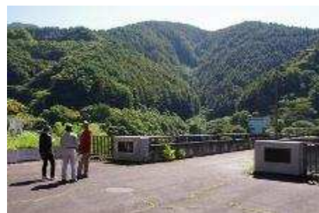
箕輪ダムの見学（10月3日） ※屋内ではマスク着用としたが、野外ではお互いに距離をとればマスクを外してもよいこととした。
