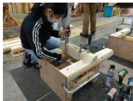
図10. 本組み開始 底面のベニヤでレベルを確保
