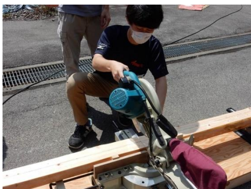
図 28 2 日目：③寸法通りに切断
