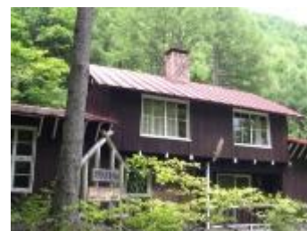
西駒ステーション
