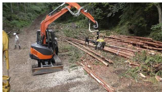
ハーベスタを操作して枝払い、玉切、集積の一連の作業を実施
