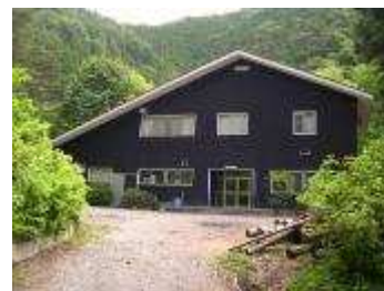
手良沢山ステーション
