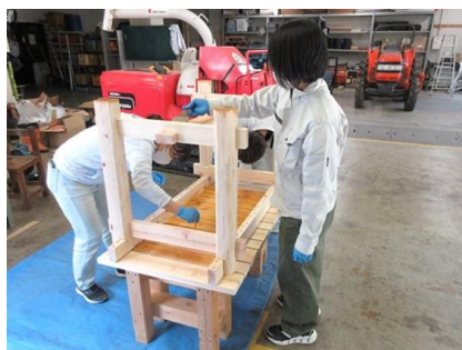
塗装作業（4日目）
