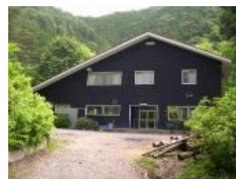
手良沢山ステーション
