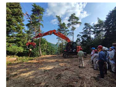
生産間伐学生実習
