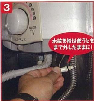
3 湯沸かし器の水抜き栓を外す。これで、台所の水道と湯沸かし器の水抜きが同時に完了
