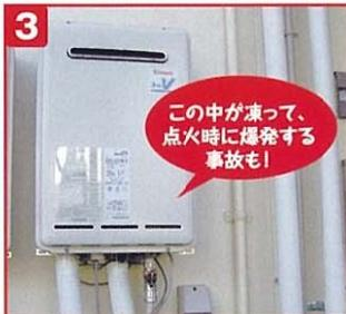
3 給湯器の本体は屋外に設置されているため、室内よりも凍結しやすい。予想気温に注意し、冷え込むようなら必ず水抜きをしよう。
