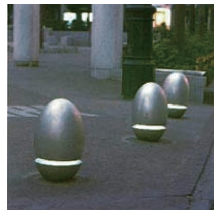
照明器具もかねた車止めの例
