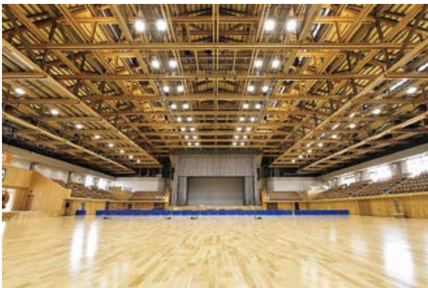
カラマツ集成材を用いた建築物の例(長野県立武道館)
