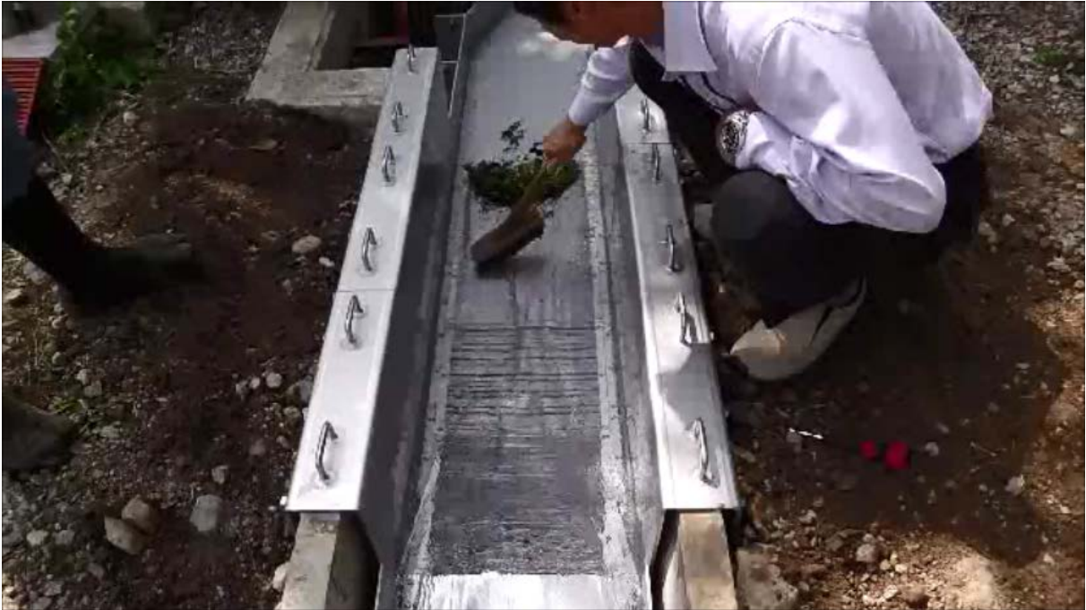
写真 2-5 スクリーン除塵状況
