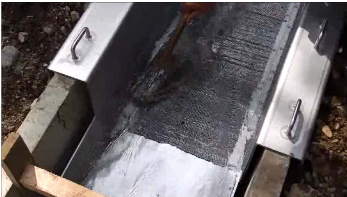
写真 2-4 新除塵機での目詰まり状況
