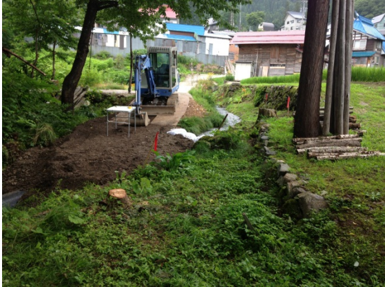
写真 2-7 発電取水口施工前の仮締切
