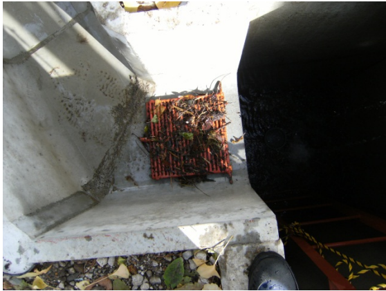
写真 2-15 トラロープの先に水位計が設置
