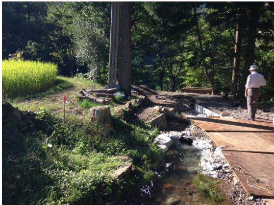
写真 2*9 新設取水口付近の流況①
