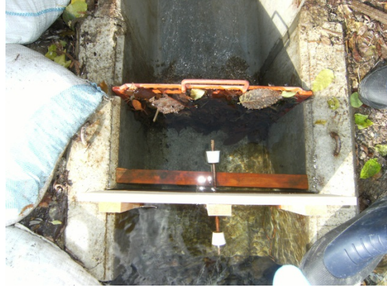
写真 2-14 取水口塵芥状況
