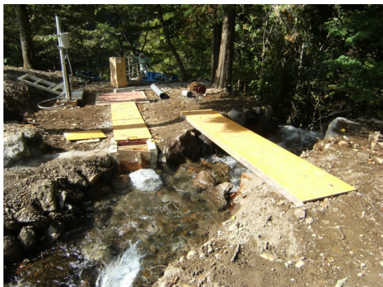
写真 2-11 取水口施工状況
