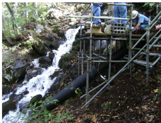
写真2-18 発電設備配置計画と違った放水路施設
