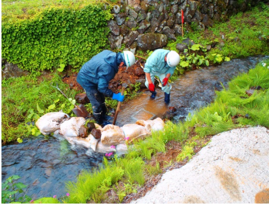
写真 2-1 水位計設置用のマス設置
