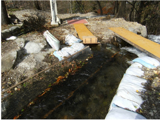
写真 2-13 取水口付近流況
