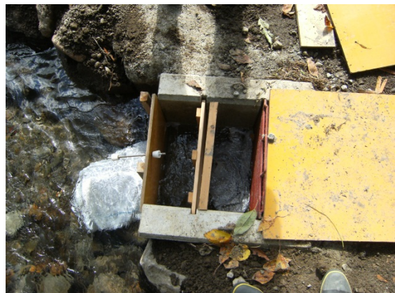
写真 2-12 取水口の流況
