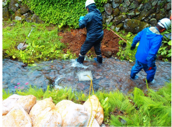
写真 2-2 水位計設置用のマス設置完了 (トラロープの先に水圧水位計設置)
