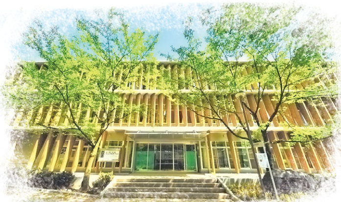
中央図書館入口
