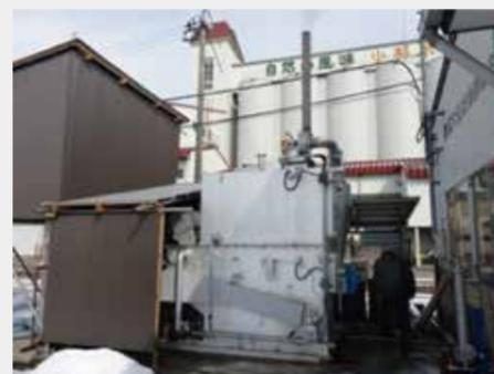
流動層式もみ殻焼却ボイラー試験炉
