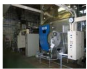
●改修後のボイラ
