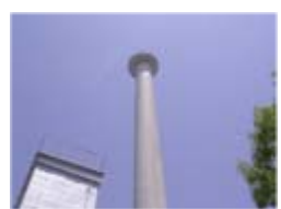
●中央ボイラ室煙突
