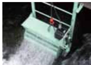
浅速流で発電するタイプの衝動水車。橋からぶら下げた2本の支柱で設置。得られた電気は水路協の民家で活用
