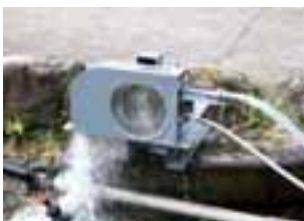
山奥のランプの宿の源泉に設置したジェット水車。電気は衛星電話の電源に。温泉水でも素材を選べばトラブルがないことを実証
