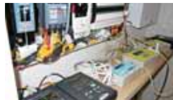
住宅の消費電力量や太陽光発電と燃料電池の発電量の計測器を分電盤に取り付けて、寒冷地の家庭の実態を計測中
