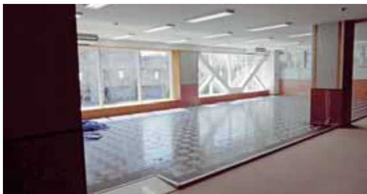
南窓側の耐震ブレース
