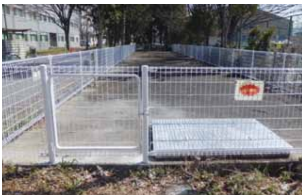
新しくなった二次貯留槽のフェンス
