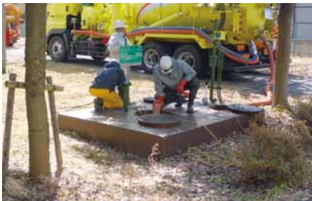
実験系排水貯留槽の清掃
