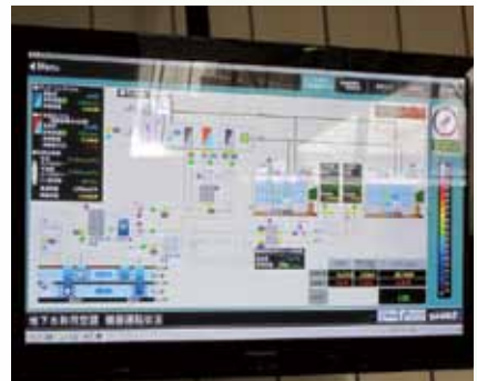
講義棟の廊下に設置されたモニター。地下水温や室温、運転モードなど、システムの状況がすべてここで確認できる
