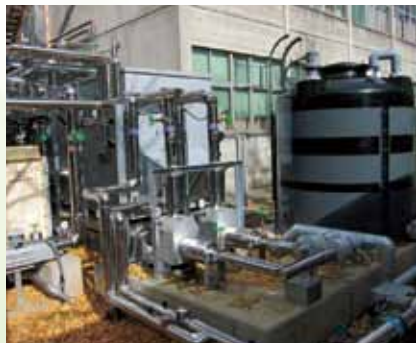
実験プラントの中心となる新開発の水冷式ヒートポンプは、水温に応じて最適な運転モードが選択できる
