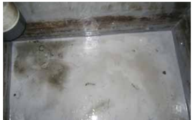
清掃後の実験系排水貯留槽内部
