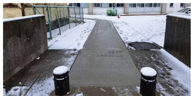
写真-3 工学部キャンパス内に設置した融雪舗装の融雪状況の一例 (令和7年3月)
