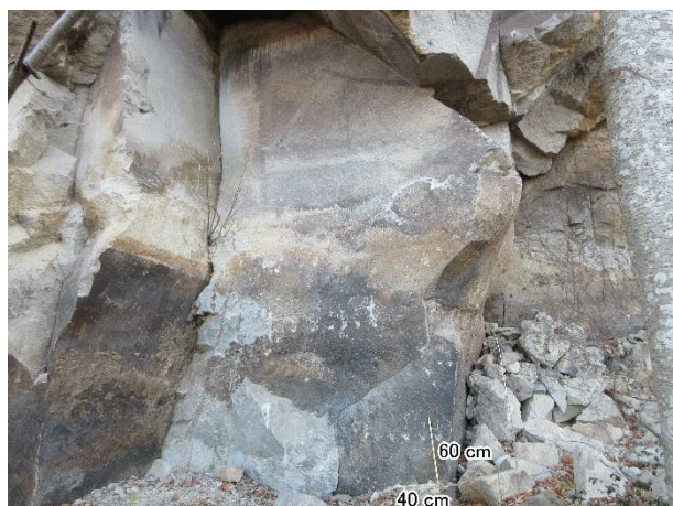
図-13 志賀溶結凝灰岩 露頭位置は図-8 の Loc.5
