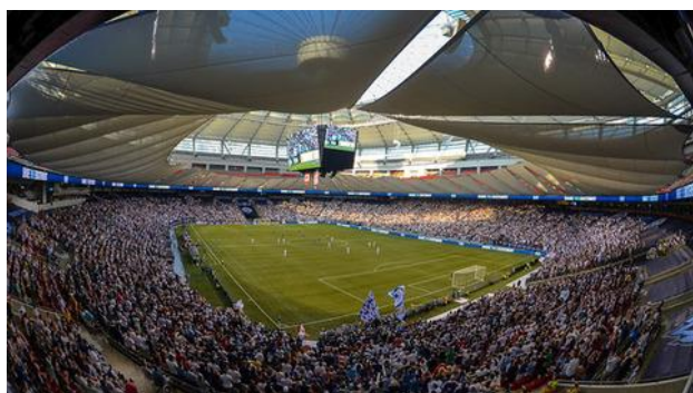
図 17 先進ファブリック (PTFE) の屋根を降下させ臨場感・劇場感を増す仕掛があるバンクーバーの BC プレイス・スタジアム
