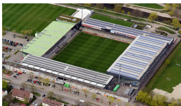
図2 ソーラーパネル付き屋根のあるシュバルツヴァルト・スタジアム
