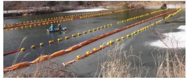
写真-2 ゼオライトシートフェンスの設置状況
