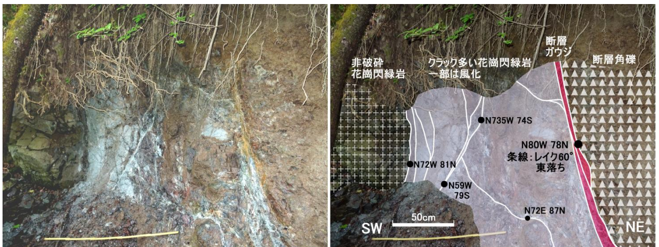
図-22a 花崗閃緑岩に変位を与える東-西走向の断層(Loc.11) 中山沢右岸標高 880m 付近.
