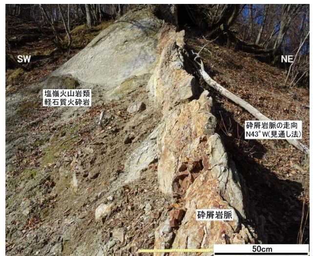
図-16 北西-南東走向の碎屑岩脈(Loc.5) 三城西方の大門沢支流.
