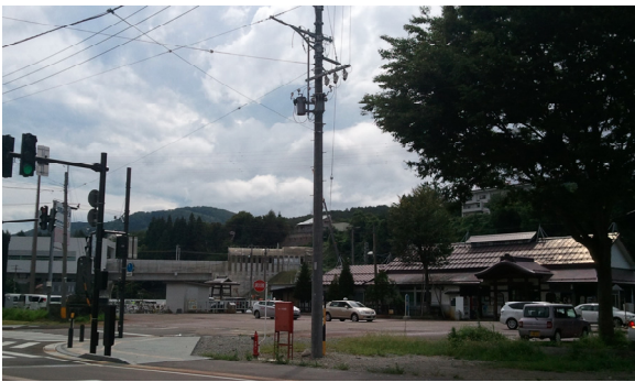
写真2 建設中の新駅（左）と飯山駅（2014年8月）
