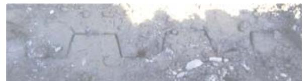
(c)塗布処理した鋼矢板の引抜き跡
