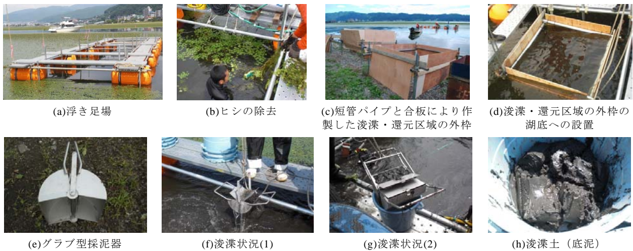
写真-2 浚渫・還元区域の外枠の設置と底泥の浚渫
