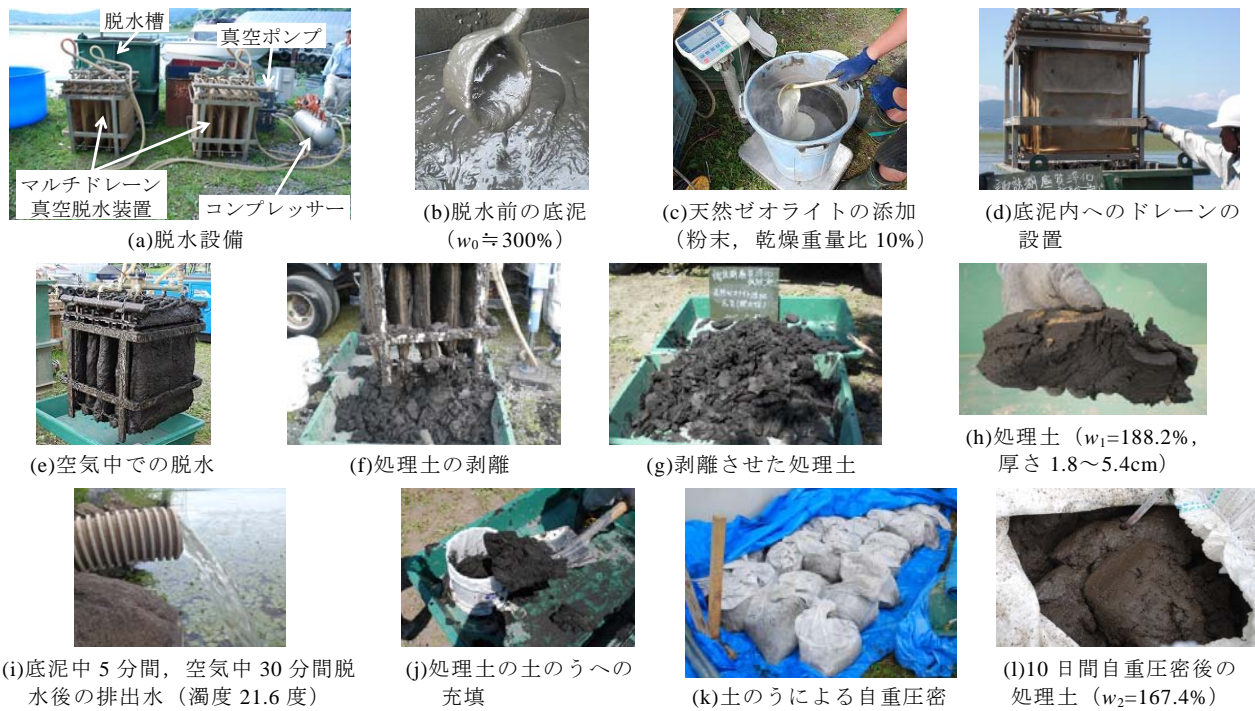
写真-3 マルチドレイン真空脱水法の施工状況
