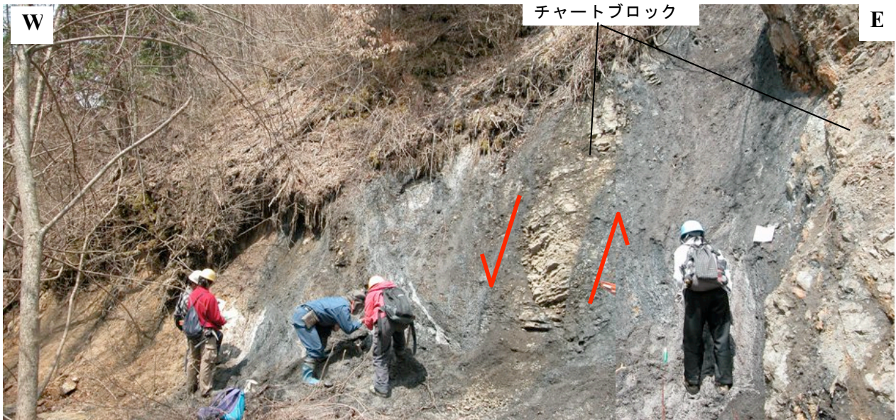
図-5. F1の露頭写真. 破碎帯幅 10m 以上 チャートブロックの引きずりより東側上昇の運動センスを読み取ることができる.
