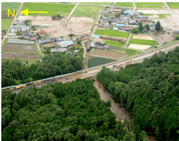
写真-1 前沢川における災害の状況 株式会社アジア航測撮影
