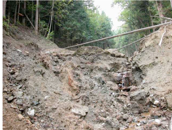
写真-19 古期河床堆積物の断面
