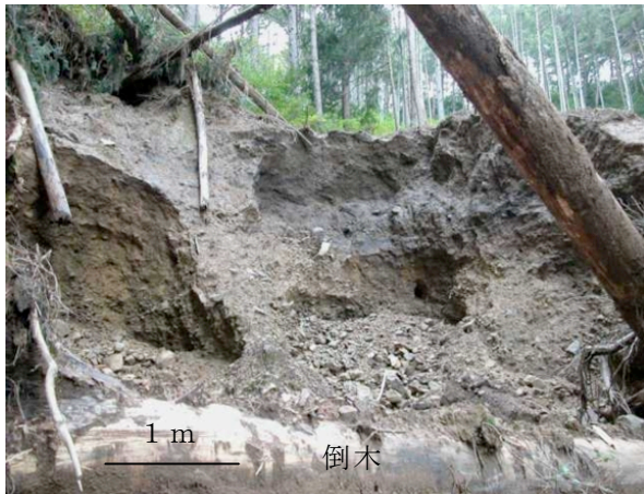
写真-14 崖錐堆積物 パイプが形成されている。
