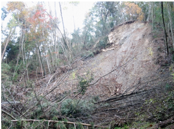
写真-16 地すべり。
