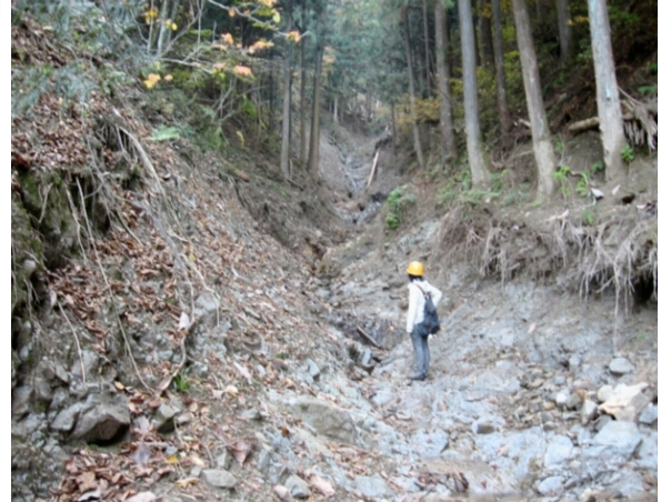
写真-15 河床の洗掘 花崗岩が露出する。
